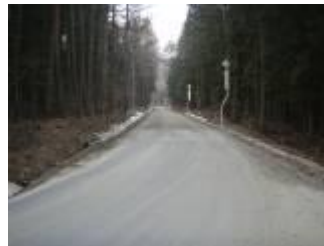
【住民により改修された道路】
