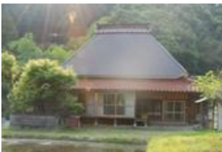
【ボランティアで再生した空き民家の外観】
