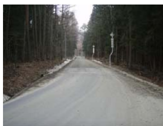
【住民により改修された道路】
