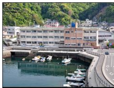
【廃校となった中学校の全景】
