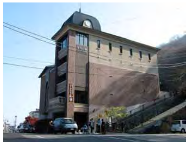
ロープウェイ駅舎が組み込まれているまちの駅
