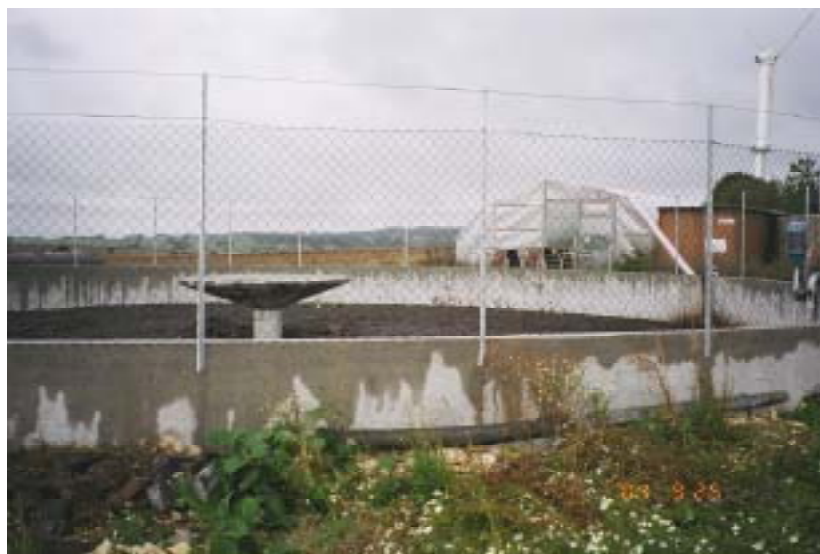
写真 2-6 先進農家（ライパーティンゲン村）のバイオガス施設、風力発電施設
