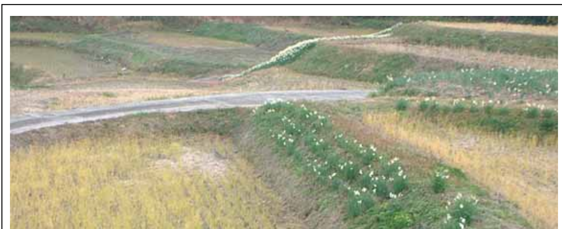
写真 6-9：法面への植栽（千葉県鴨川市）
