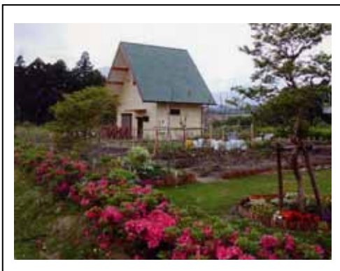
三重県いなべ市 ラウベ(休憩小屋)
