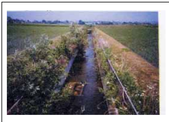
写真 6-7：二段型小排水路（栃木河内町）
