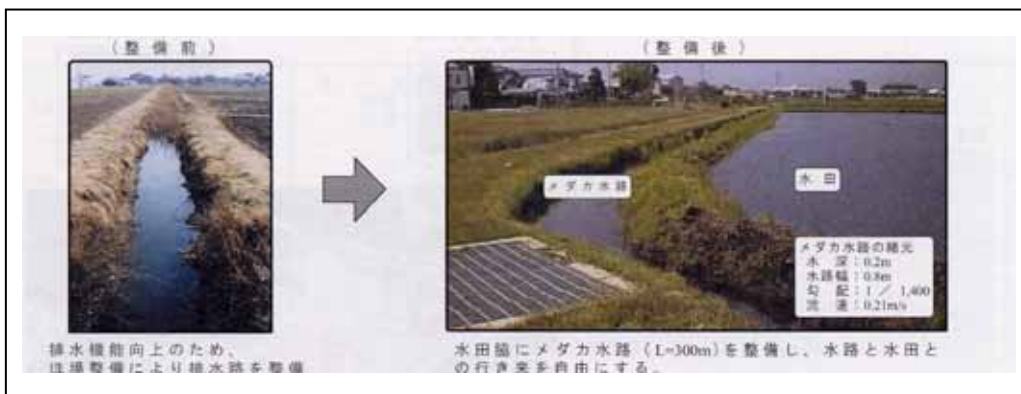
写真 6-6：魚巣付き用水路（栃木県真岡市）
