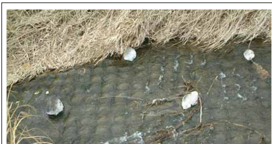
写真 6-5：勢工付き水路（栃木）
