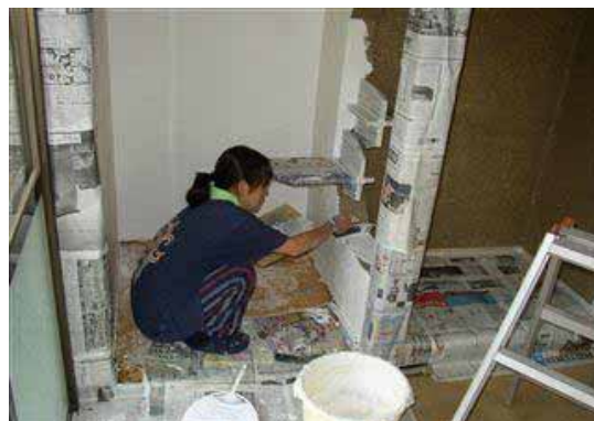
空き家を修繕するIターン者 (快適な住まいへ)
