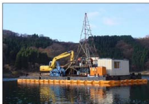
組立式台船上に設置された ボーリングマシン
