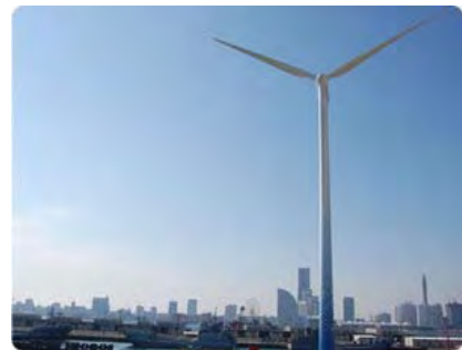
風力発電施設写真・位置
