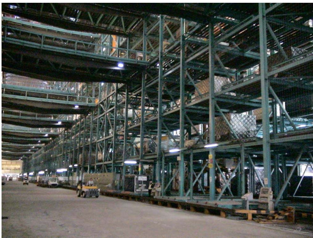
写真8 スーパーターミナル1の場内
