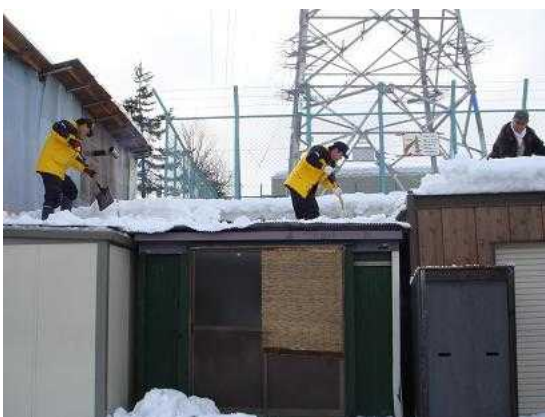
写真 3 - 7 町会施設の雪下ろし
