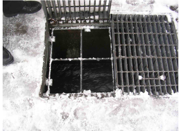
写真 3 - 14 流雪溝の流れと仕切版
