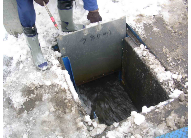
写真 3 - 16 流雪溝の流末(シューター)の様子
