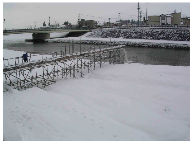
写真 3 - 16 流雪溝の流末(シューター)の様子
