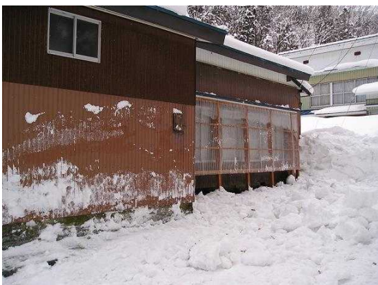
写真 3 - 33 除雪後の状況
