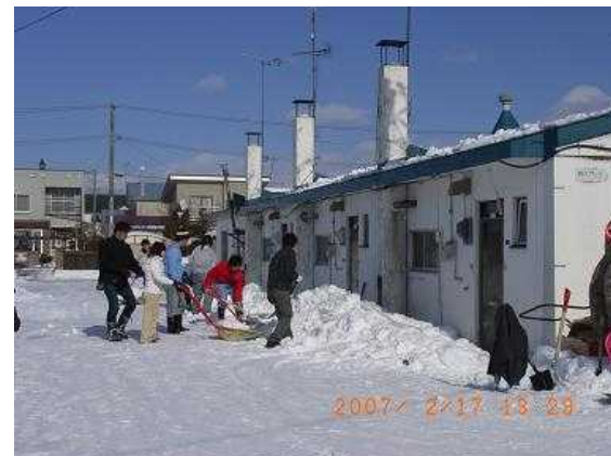
写真 1 - 12 下ろした屋根雪の運搬排雪
