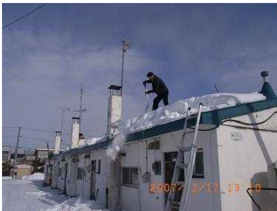
写真 1 - 11 屋根の雪下ろし (地域住民)
