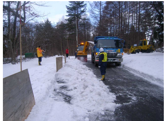
写真 2 - 12 トラックへの積み込み
