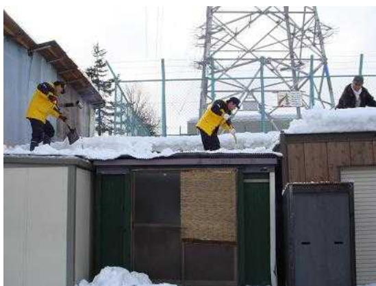
写真 2 - 7 町会施設の雪下ろし
