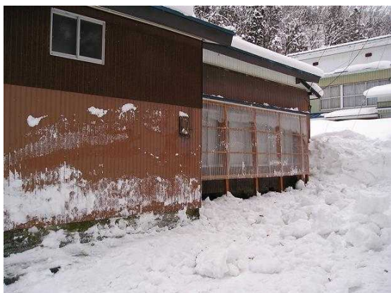
写真 3 - 17 除雪後の状況
