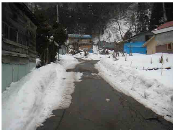
写真 3 - 11 真名子地区：地区内の中心道路
