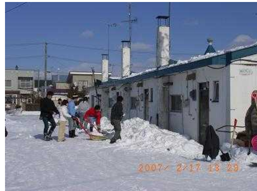
写真 4 - 4 下ろした屋根雪の運搬排雪
