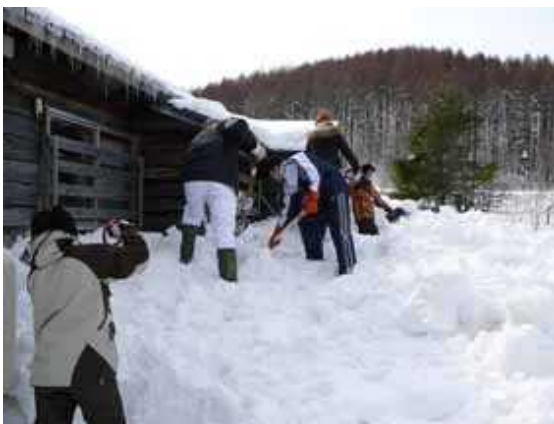
写真4-7 除雪場所 作業前
