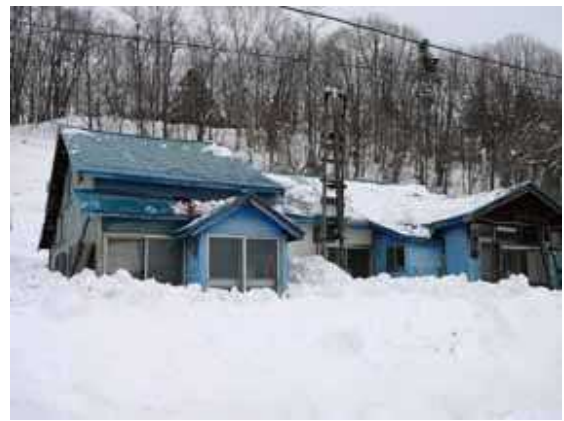
写真4-6 除雪場所 作業後
