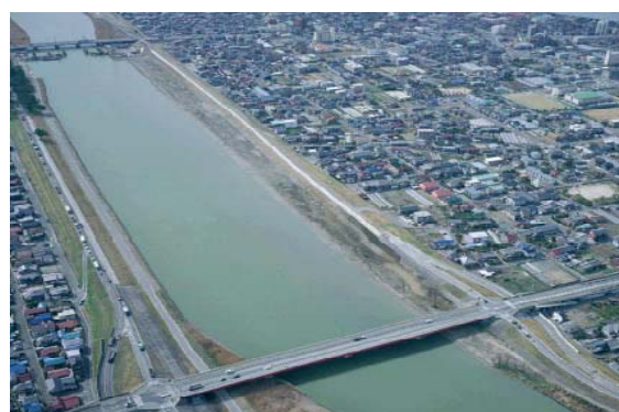
庄内川・新川・天白川激甚災害対策特別緊急事業 河道掘削・護岸整備状況 (名古屋市中川区大蟠螂地区)
