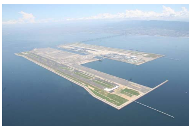
写真 関西国際空港（関西国際空港(株)提供）
