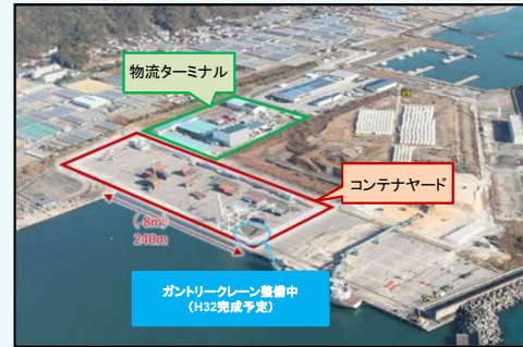
高知港三里地区-8m岸壁
