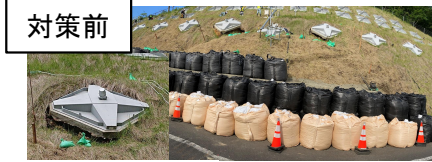
アンカーの変状 (ズレ・沈下・隙間)
