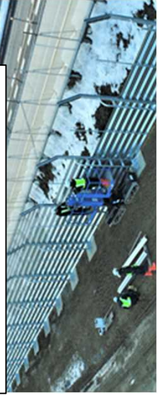
【施工中写真】防雪柵設置工
