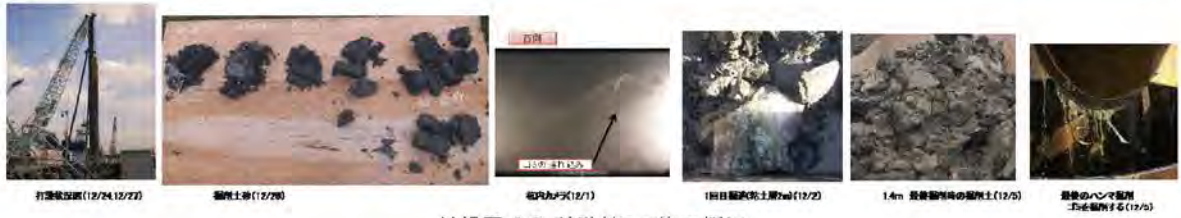
付録図-2.9 試験坑5の施工概況
