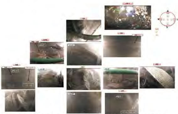
付録写真-3.7 カメラ観察画像（試験杭5の2回目）
