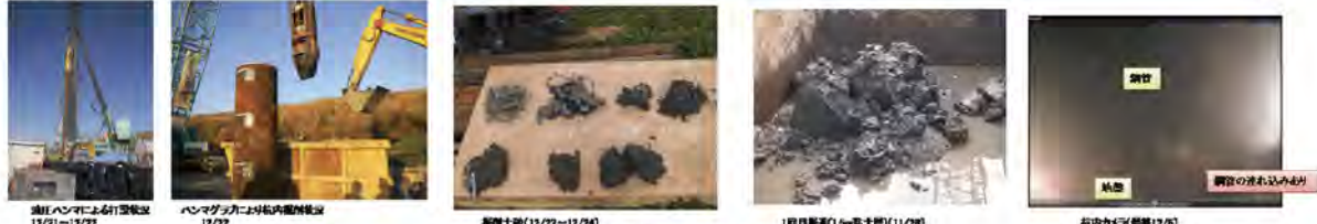
付録図-2.7 試験杭4の施工概況
