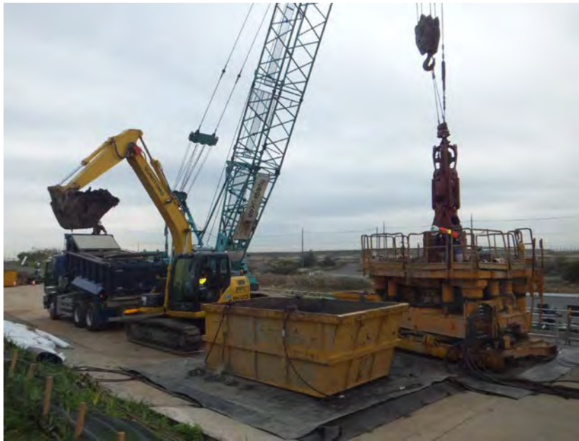
写真 2-1 ハンマーグラブによる掘削状況及びハンマーグラブ本体の写真
