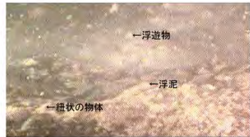
写真 2-9 掘削底面の堆積物をハンマーグラブにより除去、1日以上静置後
