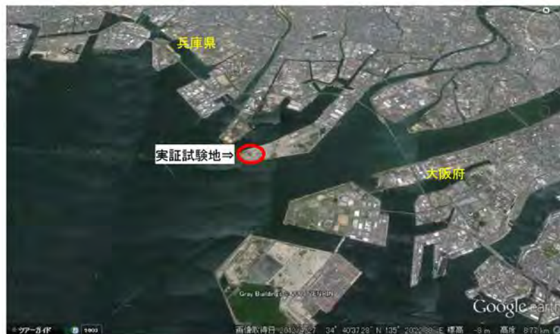
写真 1-1 尼崎沖埋立処分場管理型区域
