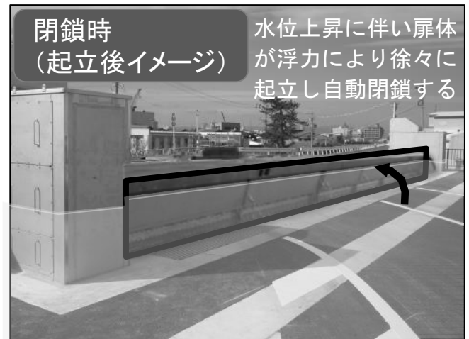
「津波等による浮力で閉鎖」するフラップゲート式の陸閘（津松阪港海岸）
