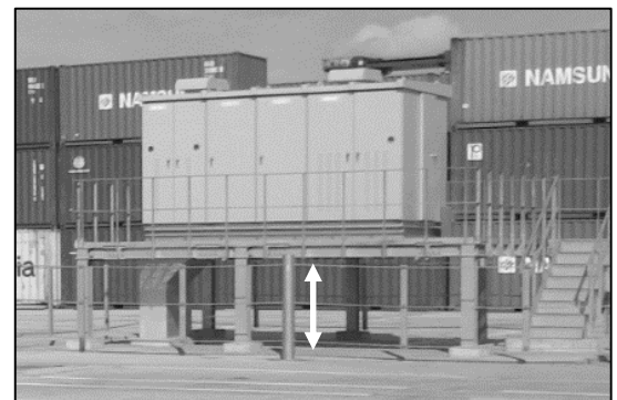
電源設備の嵩上げ
