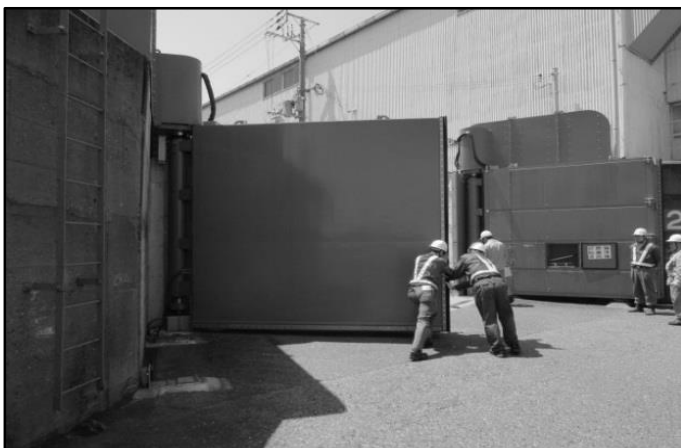
平常時の点検・訓練（大阪港海岸）
