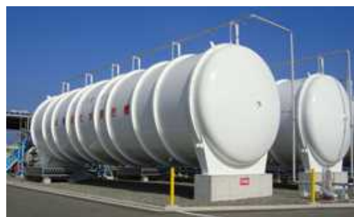
図 21: 液化水素貯蔵タンク(真空二重殻断熱構造)
