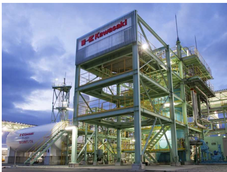
図 24:水素液化プラント(写真は液化水素製造能力 5 ton/日のプラント)
