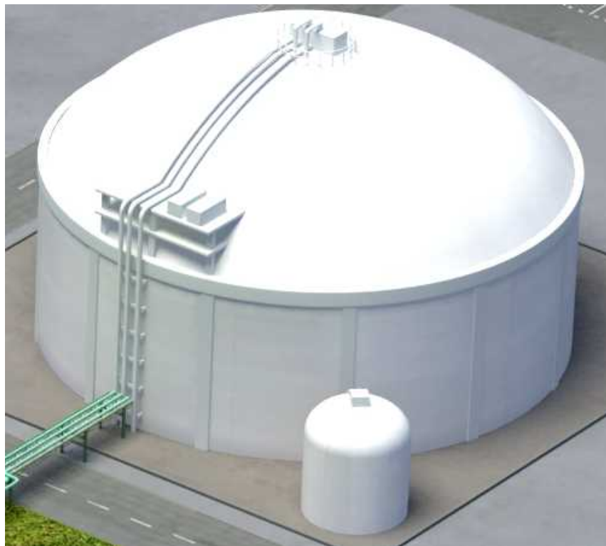
図 22:大型液化水素貯蔵タンク(常圧断熱平底円筒型)[開発中]
