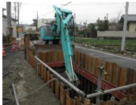
管路工事(掘削)
