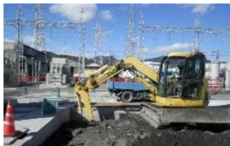
変圧器基礎工事
