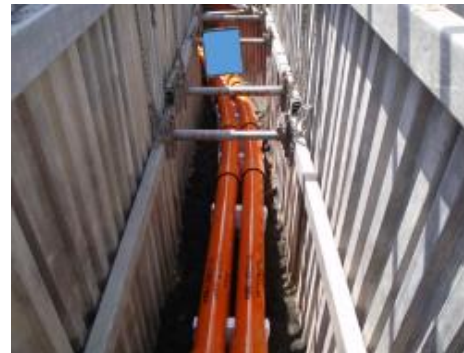
管路工事(据付)
