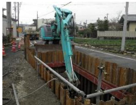
管路工事(掘削)
