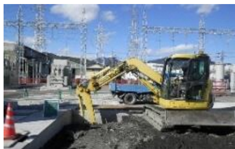
変圧器基礎工事
