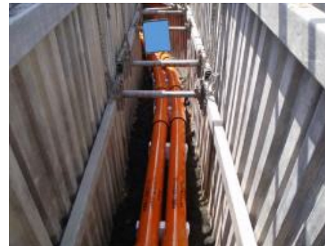
管路工事(据付)
