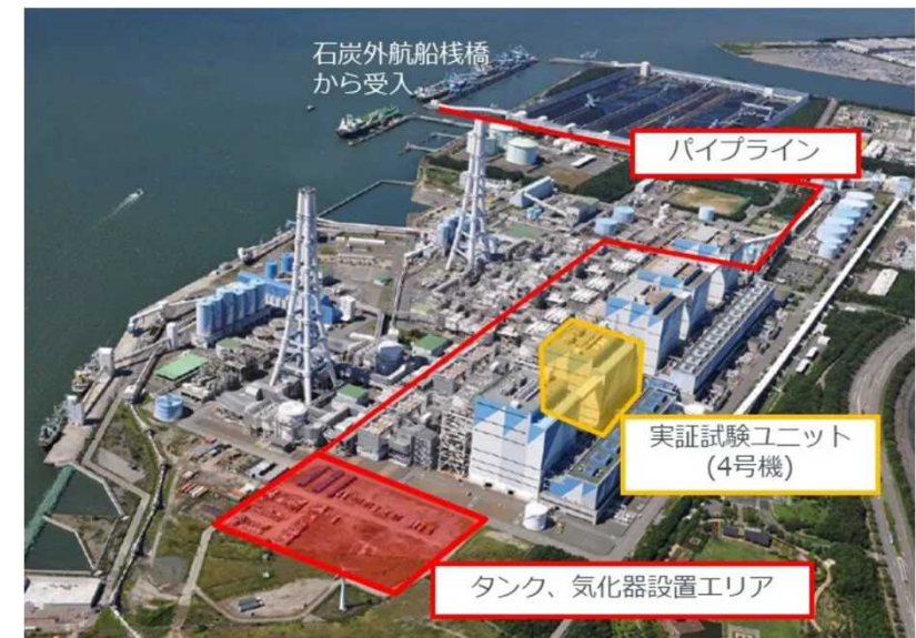
大規模実証のイメージ(碧南火力発電所)
