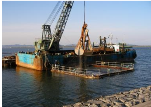
図 3.13.11 覆砂工事施工状況
