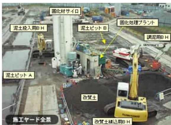
図 3.20.8 再生石膏粉を原料として用いた固化材・改質剤の利用事例
