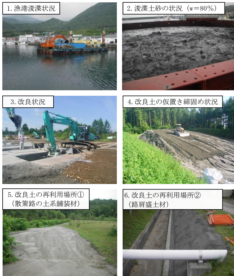
図 3.25.6 漁港浚渫の施工事例
