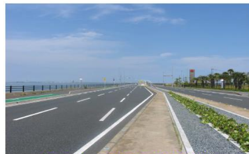
新北九州空港連絡道路
