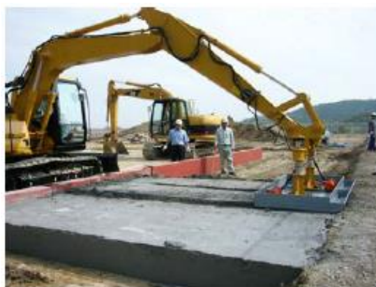
図 3.13.2 施工（締め固め）状況
