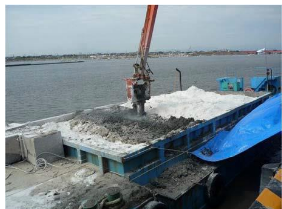
図 3.20.8 再生石膏粉を原料として用いた固化材・改質剤の利用事例
