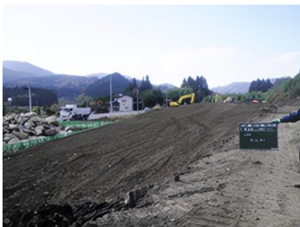
③改質土の撒き出し状況
