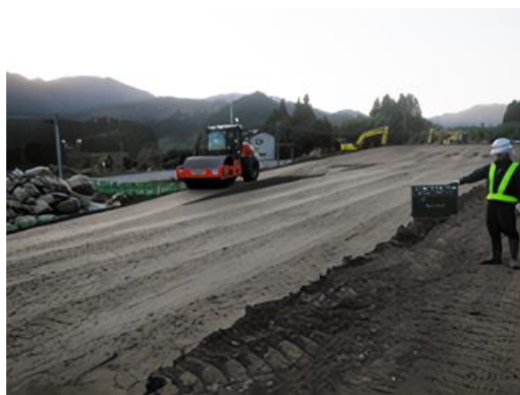
④改質土の転圧状況
