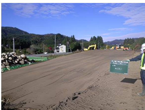
⑤改質土の転圧完了
