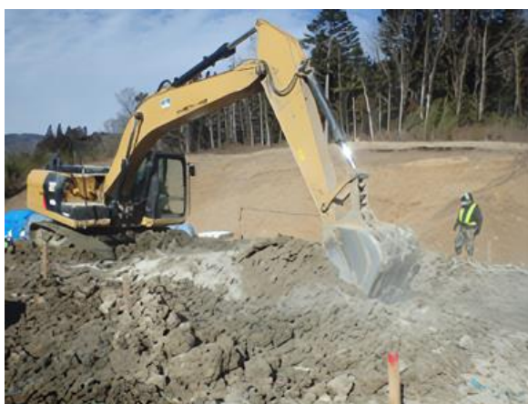
②PS 灰系改質材による改良状況
