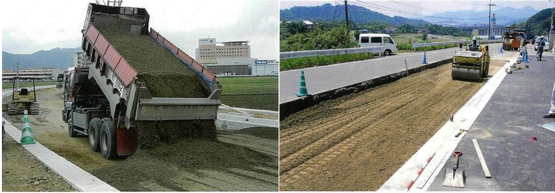
図 3.26.7 HC 複合路床材料の施工状況
