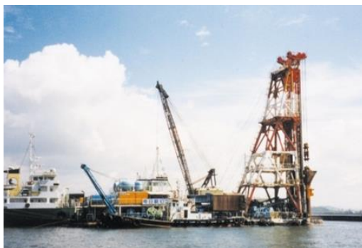
図 3.13.10 SCP 施工状況
