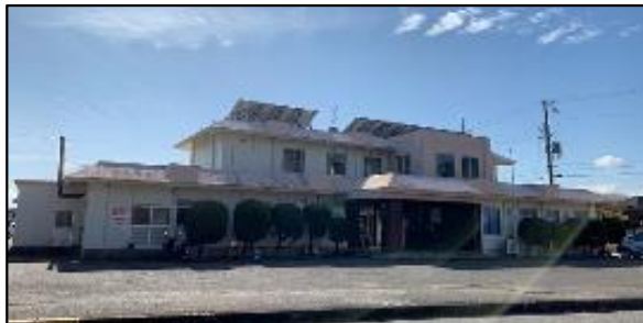
新宮港湾会館
