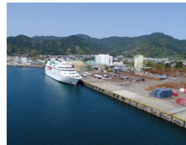
三輪崎第四岸壁・荷捌き地
