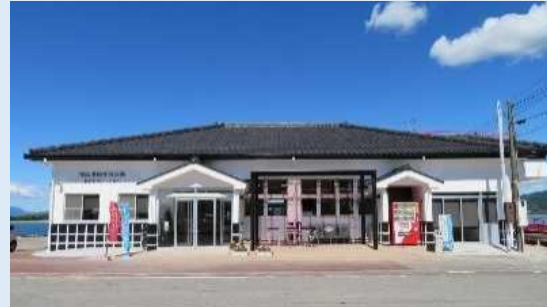
苓北町富岡港船客待合所 (きずなステーション)
