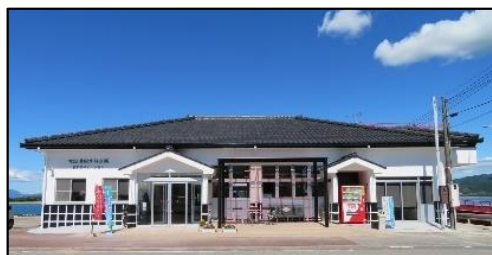
苓北町富岡港船客待合所 (きずなステーション)
