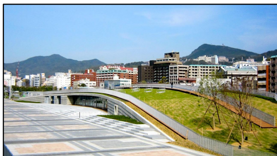
松が枝国際ターミナルビル
