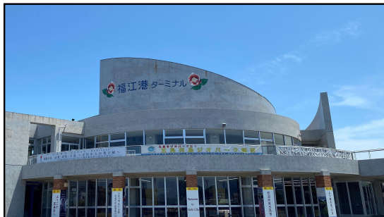
福江港ターミナルビル
