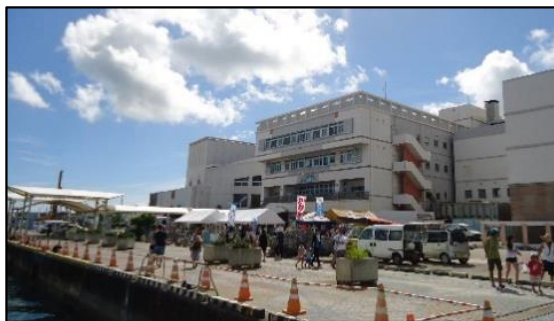
平良港マリナーミナルビル
