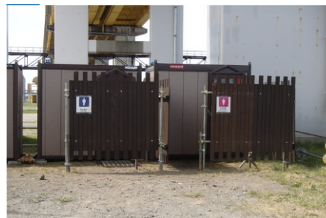
準備工の仮設トイレ設置
