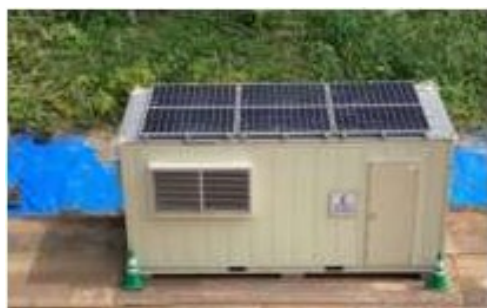
準備工の休憩所設置
