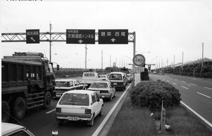
●海底トンネルの整備による渋滞緩和の様子 2車線対面通行時
