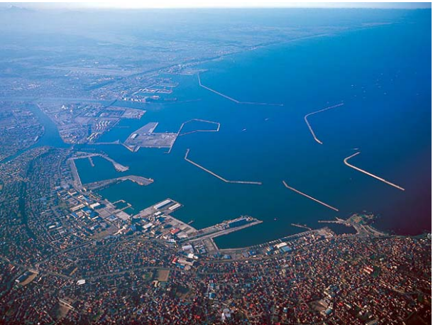
【八戸港の全景】
