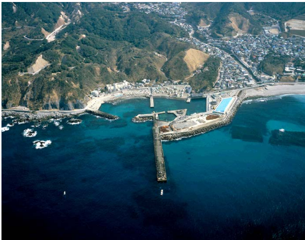
【神津島港の全景】
