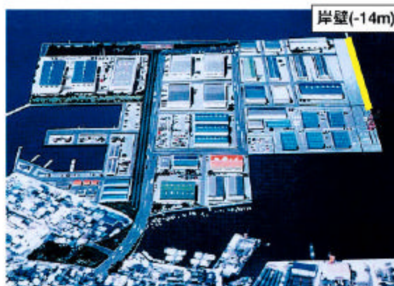
▲多目的国際ターミナルならびに港湾を利用する臨海部立地企業(イメージ図)
