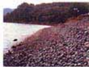
近々浜づくりが完了した海岸（静岡県伊豆市）
