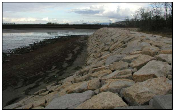
未整備区間に整備された捨石堤
