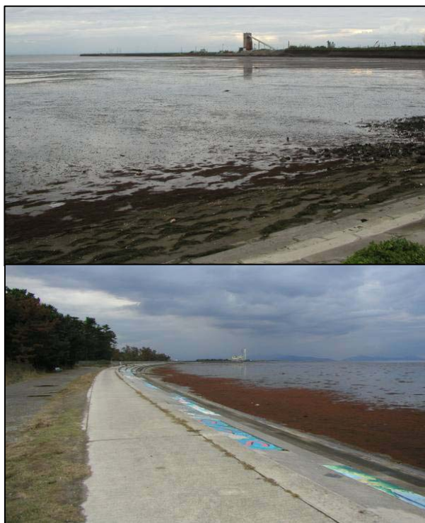
上：中津港干潟（正面は中津港） 下：既設の階段護岸
