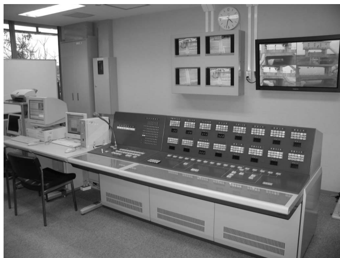
相良港海岸（静岡県）
