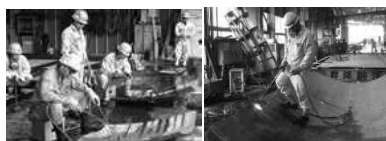
ぎょう鉄(鉄板曲げ加工)
