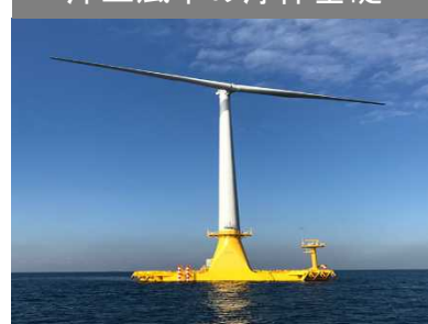
洋上風車の浮体基礎
