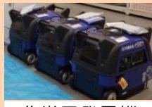
非常用発電機
