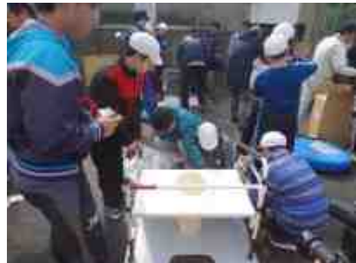
授業の一環としてマンホールトイレを組立(豊川市)
