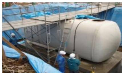
工場製作型 極小規模処理施設
