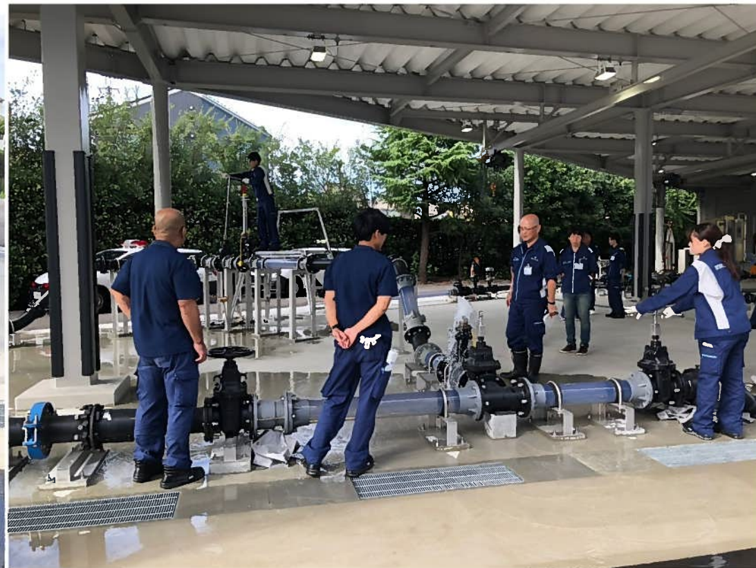
③水道維持管理(濁水解消作業)
