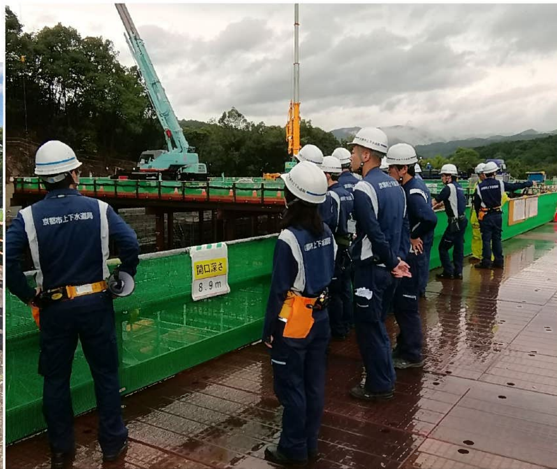
⑬水道施工【施設】(配水池改築工事見学)
