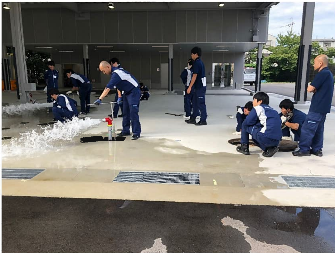
③水道維持管理(消火栓放水作業)
