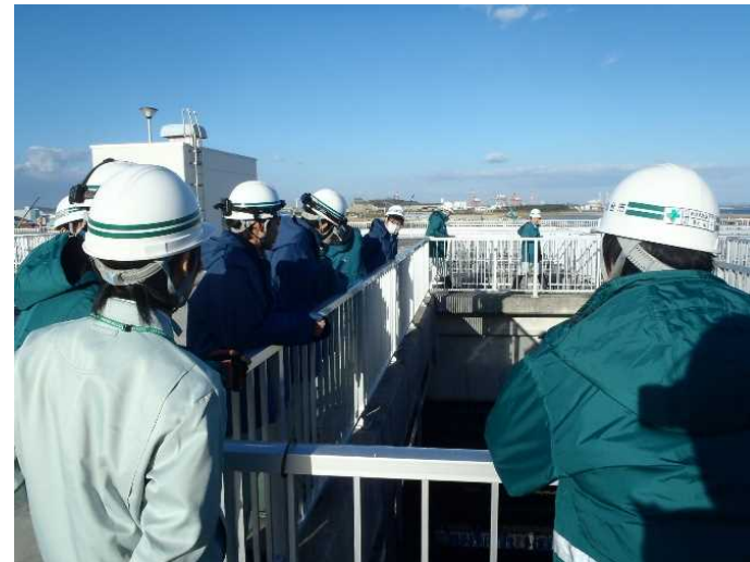
最終沈殿池の点検
