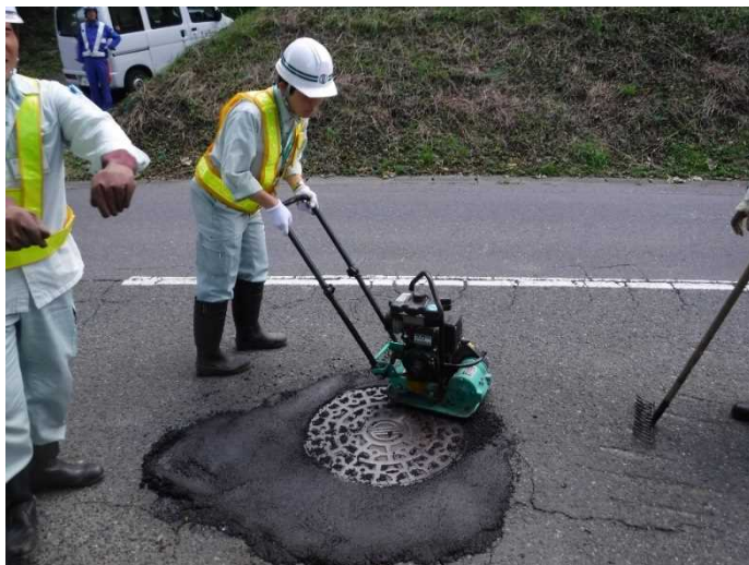
人孔周辺割れ、窪み修繕
