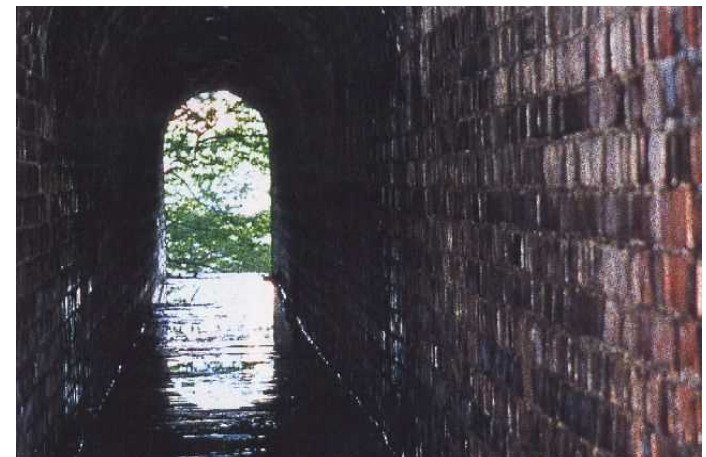
仙台市煉瓦下水道 (土木学会選奨土木遺産)
