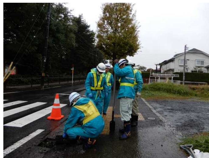
街渠柵内清掃
