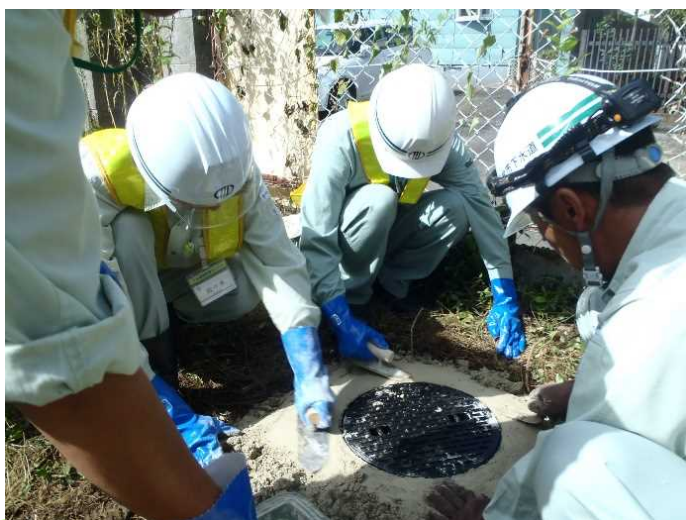
公共柵蓋の設置、修繕
