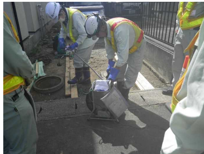
取付管カメラ調査
