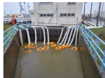
排水ポンプ車による応急対応の状況
