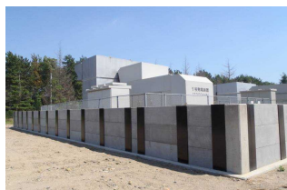
防水壁の設置
