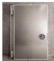
防水扉の設置
