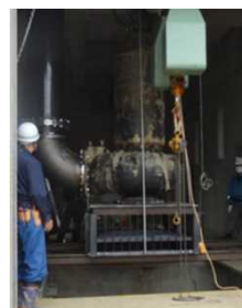
仮設ポンプの設置
