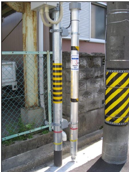
浸水警報装置（サイレン）・水位計・浸水計 稼働日：平成22年6月1日
